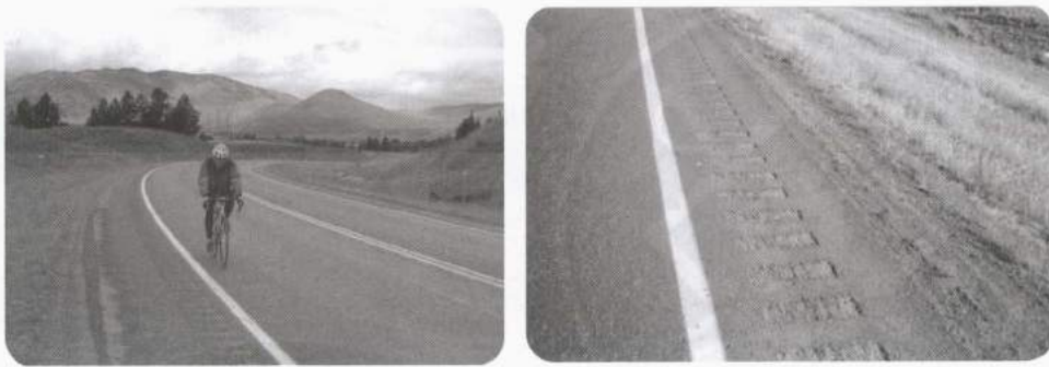
รูปที่ ๒๕ ตัวอย่างการติดตั้งแถบชะลอความเร็วข้างทางที่ระยะไม่เพียงพอ สำหรับรถจักรยาน/จักรยานยนต์
