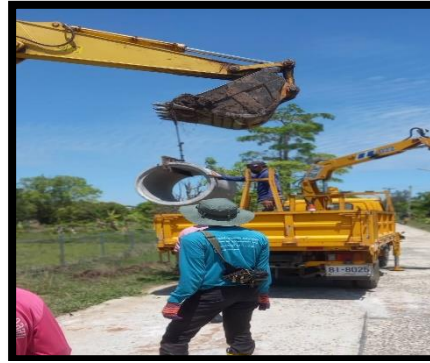
การขุดลอกร่องและวางท่อระบายน้ำ ณ ทางข้ามทางรถไฟ ตำบลทะเลเม่นชัย อำเภอลำปลายมาศ จังหวัดบุรีรัมย์
